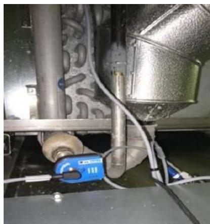
Датчик, установленный на выходе воздухоохладителя DX в Австралии
