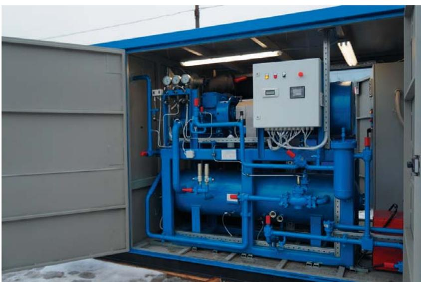
Рис. 3. Мобильные чиллерные установки контейнерного типа для замораживания грунта (ГУП «Водоканал Санкт-Петербурга»)
