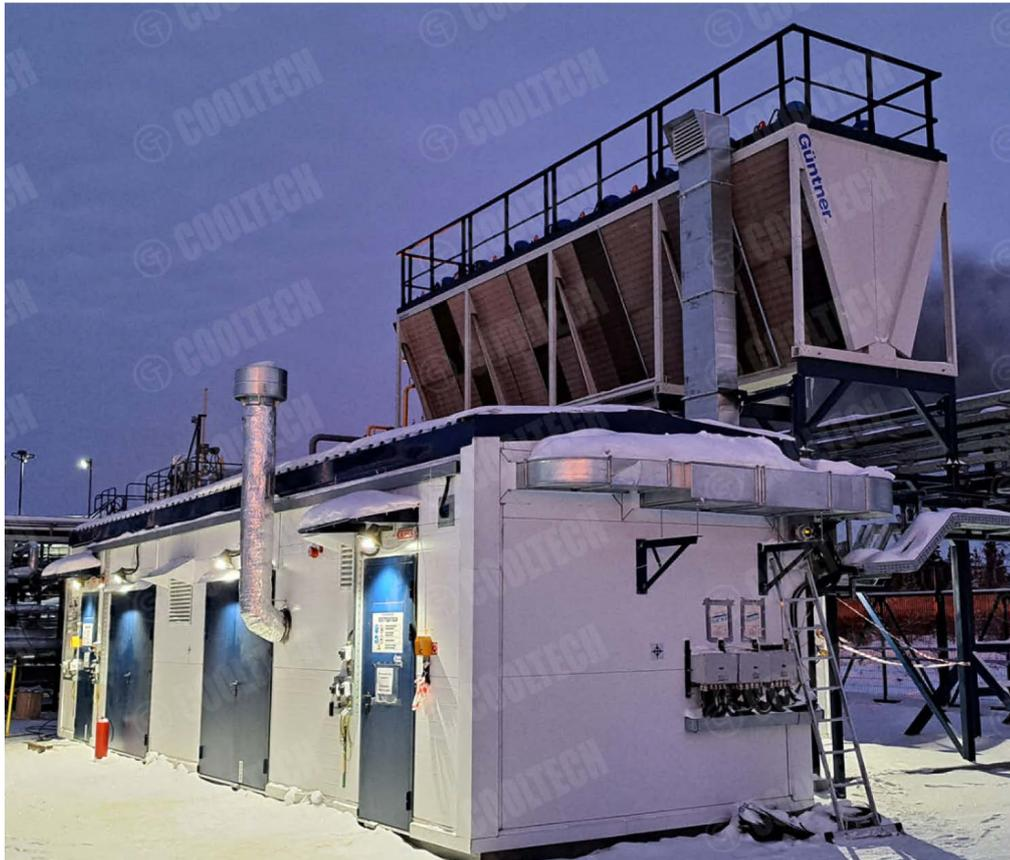
Установки COOLTECH уличного, контейнерного или блочно-модульного исполнения позволяют автономно на меторождении осуществить процесс осушки газа для последующей передачи его к потребителю.
